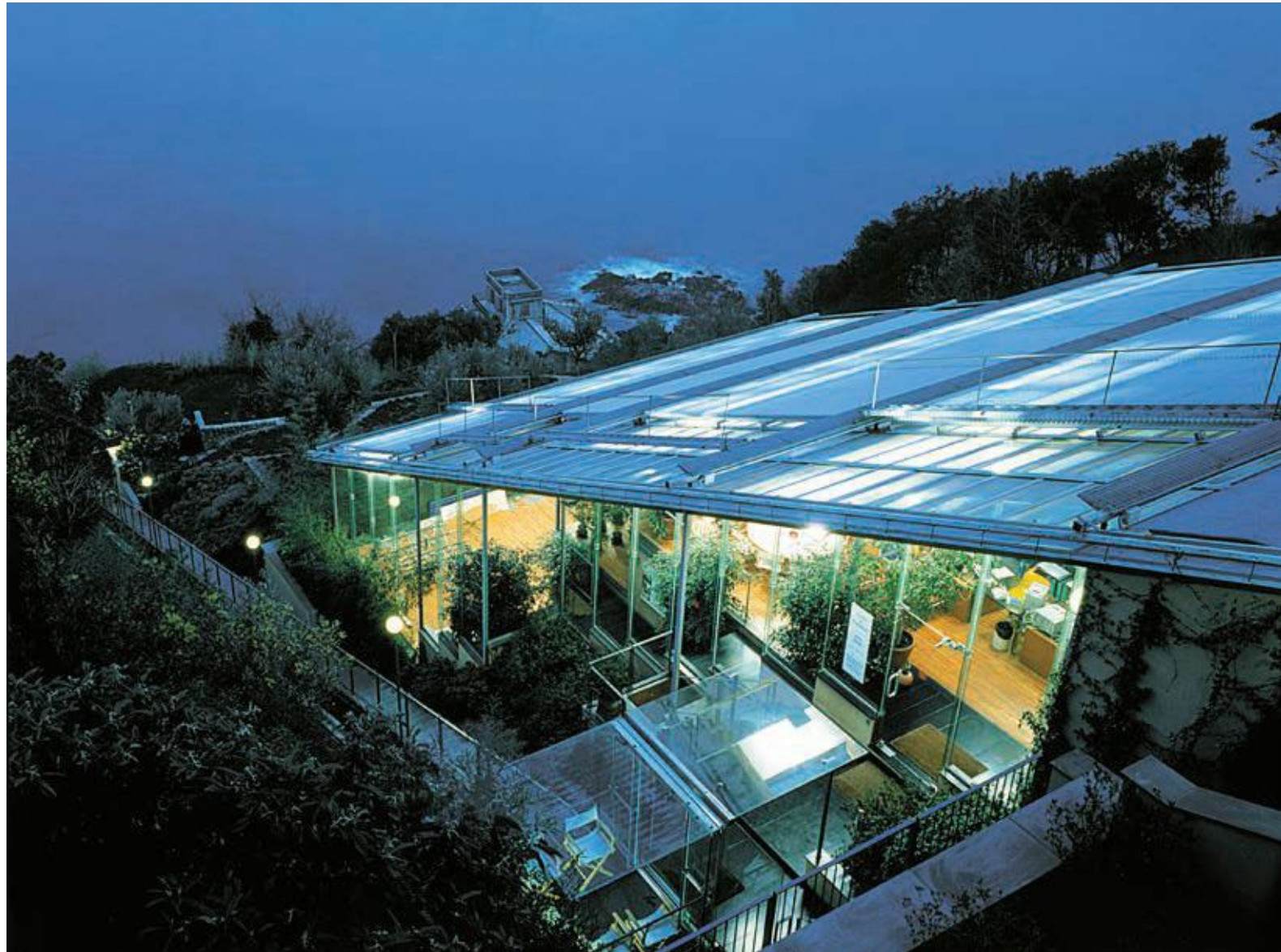
1991 Renzo Piano Taller de Construcción Génova, Italia
