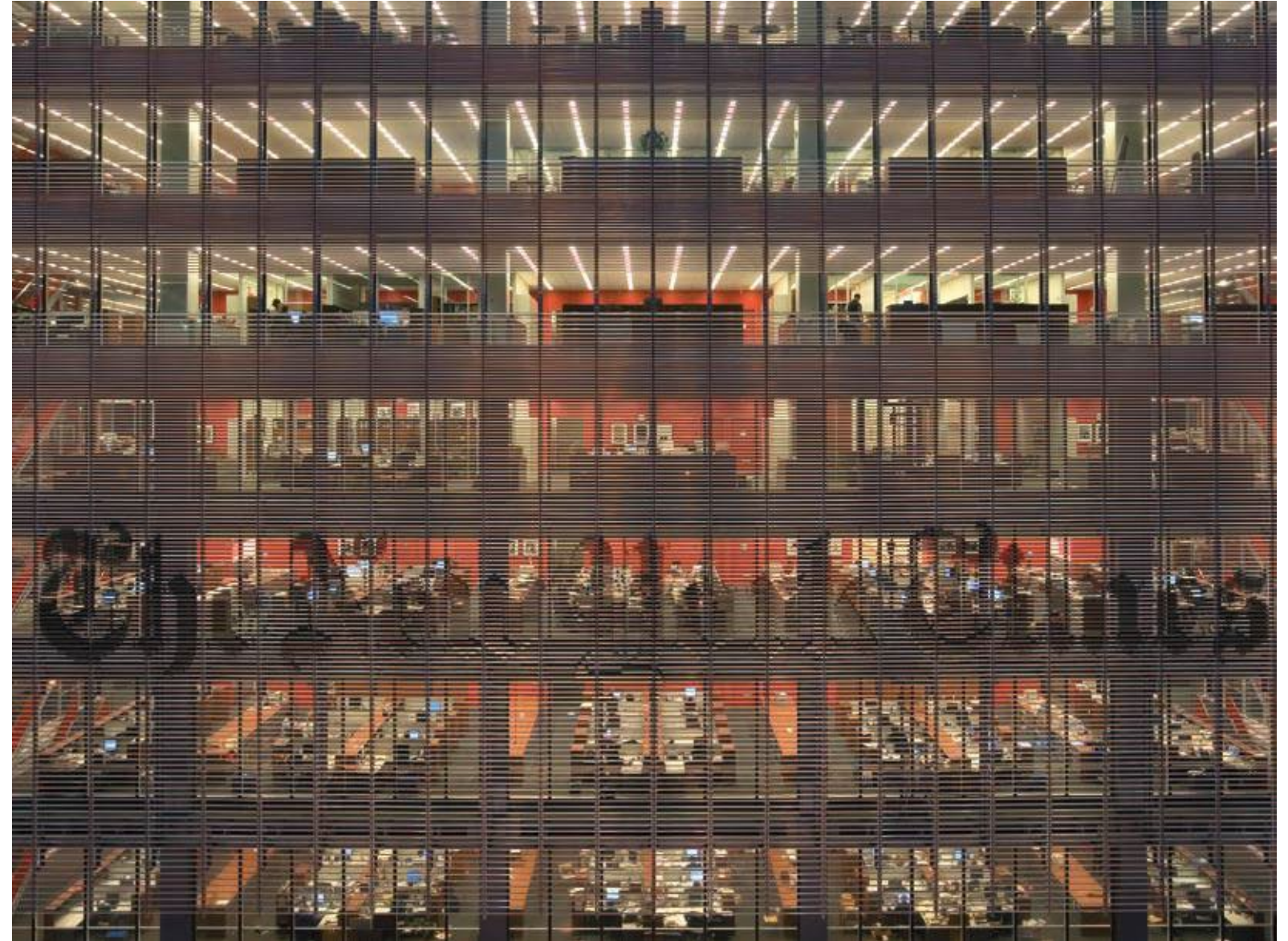
2007 Edificio de The New York Times Nueva York, EE. UU.
